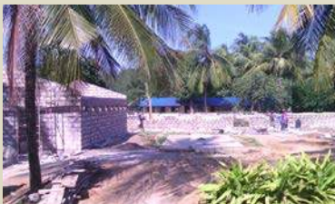
Toiletten und Schlafsaal
