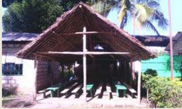
Für den Kindergarten wurde die Esshalle renoviert und neu gedeckt
