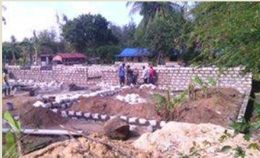
Bau der Schlafsäle – im Hintergrund die Farm und die neue Bücherei
